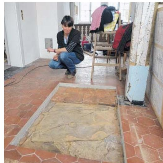
**Historischer Grund:** Bei den Arbeiten wurden unter den sechseckigen Fliesen älterer Bodenbelag gefunden. Die viereckigen Tonziegel wurden über Bruchsteinen verlegt. Ein ähnliches Bruchsteinpflaster als Bodenbelag gibt es im Kellerraum der Kurie von Schele zu Kuhoff. Das wird nebst Mauern und Gewölbe einem vorreformatorischen und zum Kloster gehörigen Bau zugerechnet.
