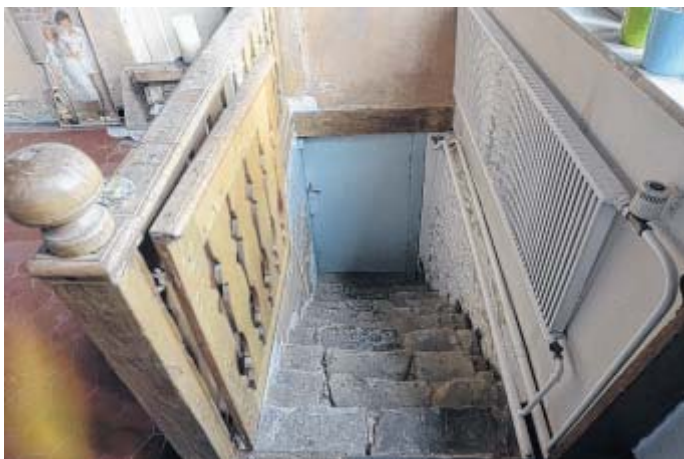
Historisches Pflaster: Die Treppenstufen zum Keller sind aus Natursteinplatten gemauert.
